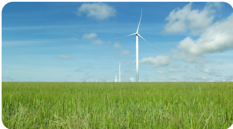
Parc éolien de Vallée de l'Arce (10)
